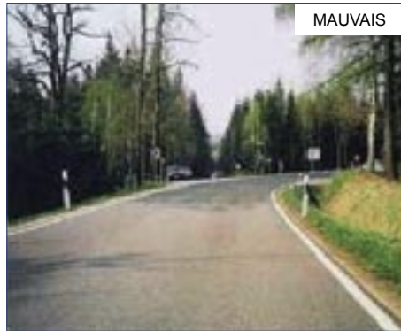
Figure 40: Erreur optique : le cours de la route va à droite au contraire de la ligne d'orientation droit devant (150 m avant) [22]
