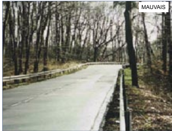
Figure 48 : Combien de signaux pouvez-vous détecter ? Tracé non visible à un virage dangereux [20]
