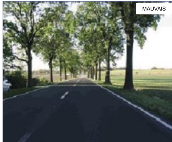
Figure 38 : Jonction non visible sur une route plantée (300 m avant) [22]
