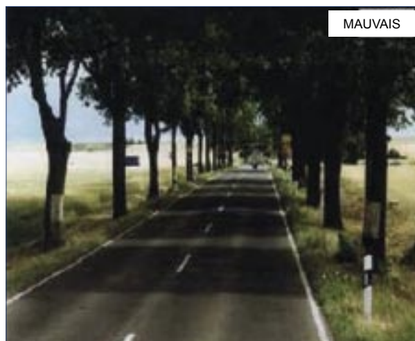
Figure 43 : Changement soudain des caractéristiques de la route : la nouvelle intersection n'est pas annoncée par une zone de transition (150 m avant) [16]
