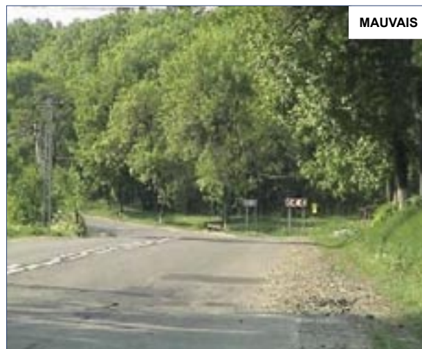
Figure 8 : Le tracé du virage n'est pas perceptible car la courbe intérieure est cachée : freinage inattendu, coups de volant et vitesse trop élevée causent des accidents [23]
