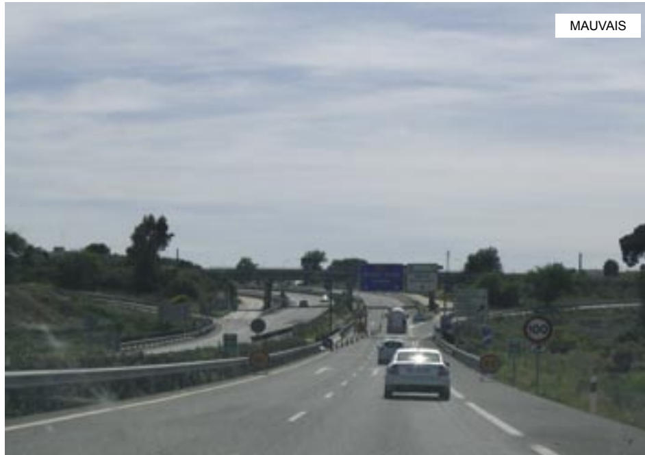
Figure 45 : Deux points critiques : zone d'entretien et une bretelle de sortie sans transition et/ou modération (150 m avant).
