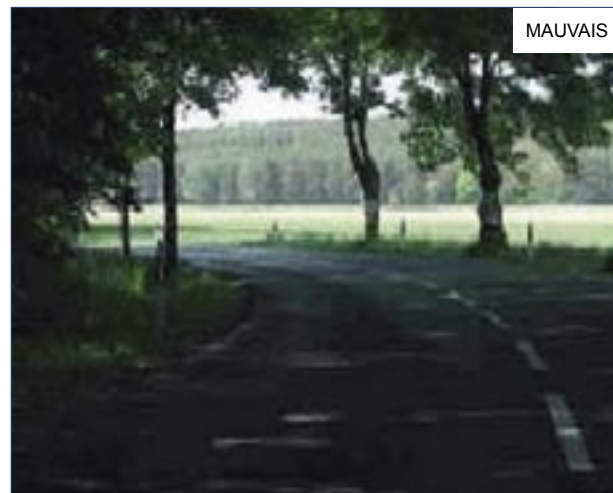
Figure 13 : Attirance vers la courbe extérieure par des lacunes trompeuses dans le dispositif, courbe intérieure non visible [22]
