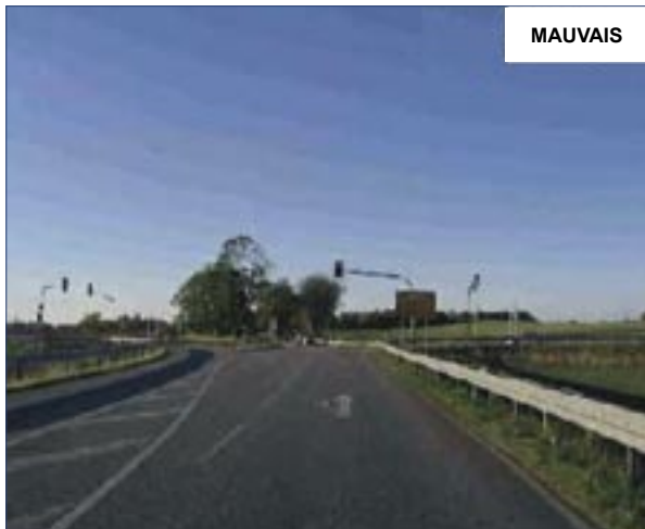
Figure 5 : Jonction, perceptible seulement 100 m avant : freinage inattendu et vitesse trop élevée à ce point causent des accidents [16]
